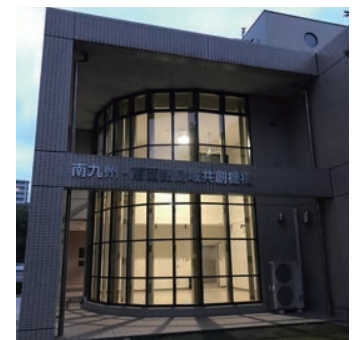
図4-7 一灯で吹き抜けの室内を照らすFGHP®ライト
