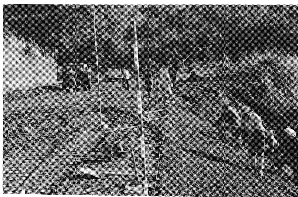
⑤ 道路新設工事（昭和41年当時）
