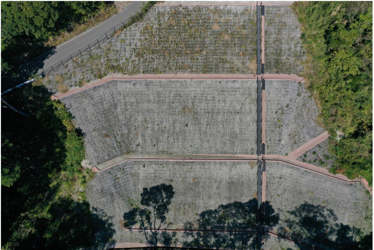
写真3-7 UAVによる調査対象法面の空撮画像
