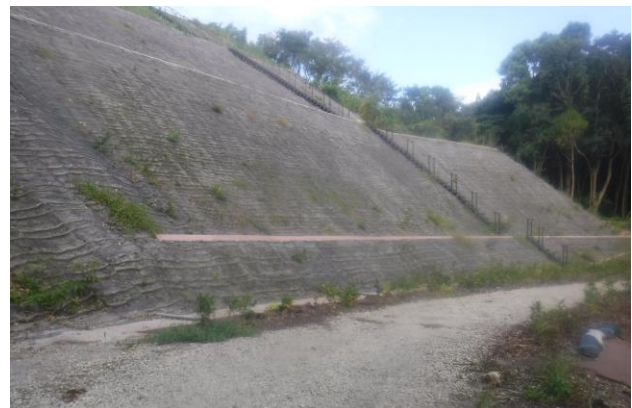
写真3-4 寺山炭窯跡付近の自然侵入促進工が施工された法面 (2022年9月22日 著者撮影)
