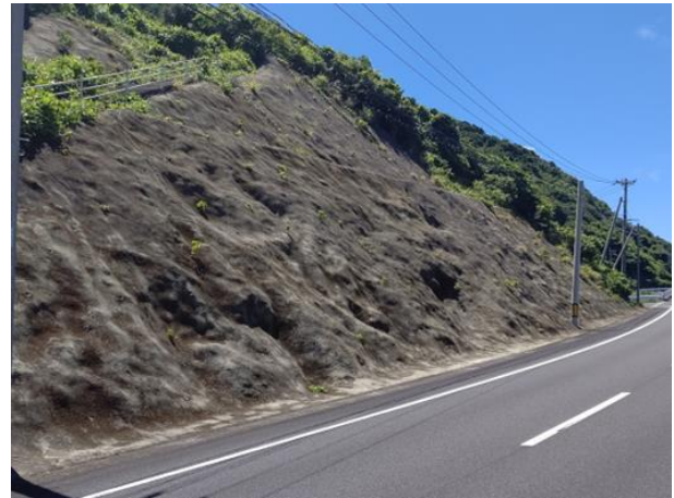
写真1-2 構造物工が施された法面
