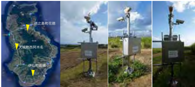
図4-12 徳之島フィールドサーバ設置場所とフィールドサーバ（左、徳之島町；中央、天城町；右、伊仙町）
