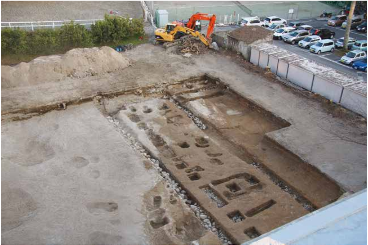
1 表土除去後の状況（南側）
