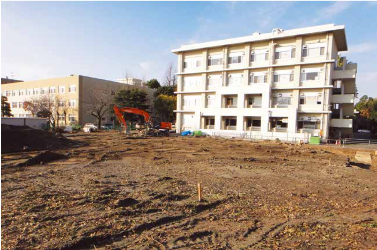
1 発掘調査前の調査区
