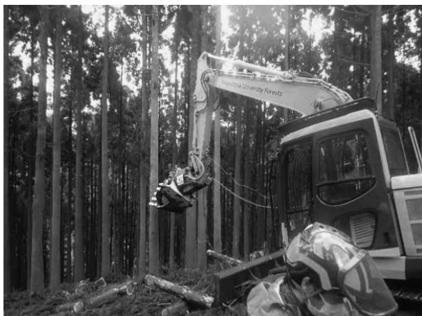
図-3 作業現場の確認
