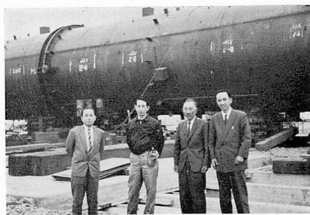
第II-3図 丸善石油関東製油所 据えつけ前の10万バレル/日能力の精留塔
