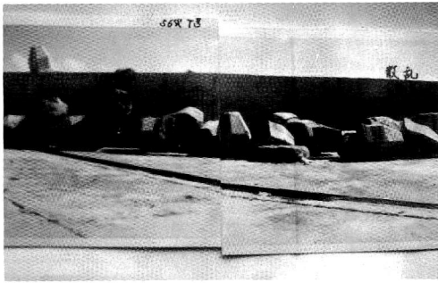
写真2 7.5mの高さの堤防を越 えてきたブロックの破片
