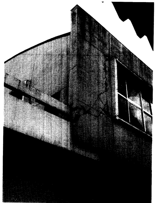
写真-6.6 非構造壁の破壊 (4月12日)
