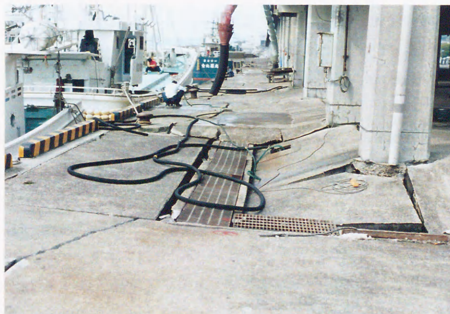
写真-3 阿久根漁港エプロン部周辺沈下状況
