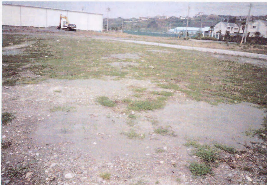
写真-2 鹿児島県北西部地震における埋立砂の液状化現象 (鹿児島県阿久根市阿久根漁港の埋立地にて撮影)
