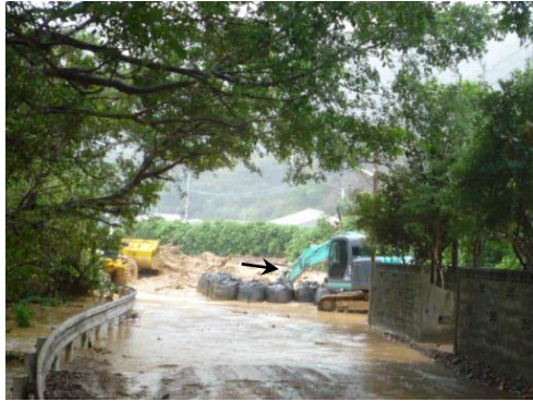
写真-1 豪雨時（2011年9月27日）の浦川
