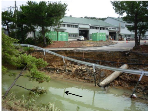
写真-3 浦川右岸の被災状況
