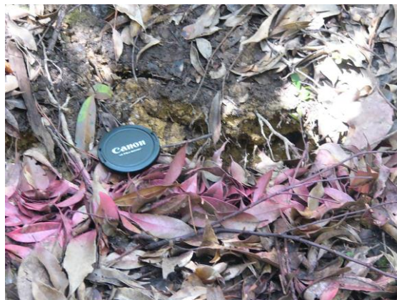
写真 2 クリープ域内でみられたクラック
