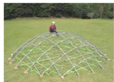
写真 2 プレース挿入後のシェル
