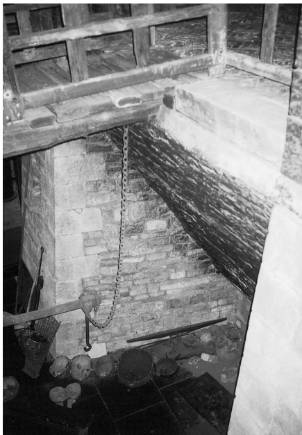
写真3 出銑口側開口部
