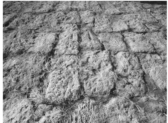
新波止の石敷き床面
