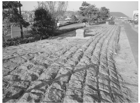
水族館側に残る曲面状の仕上げ（第二防波堤）
