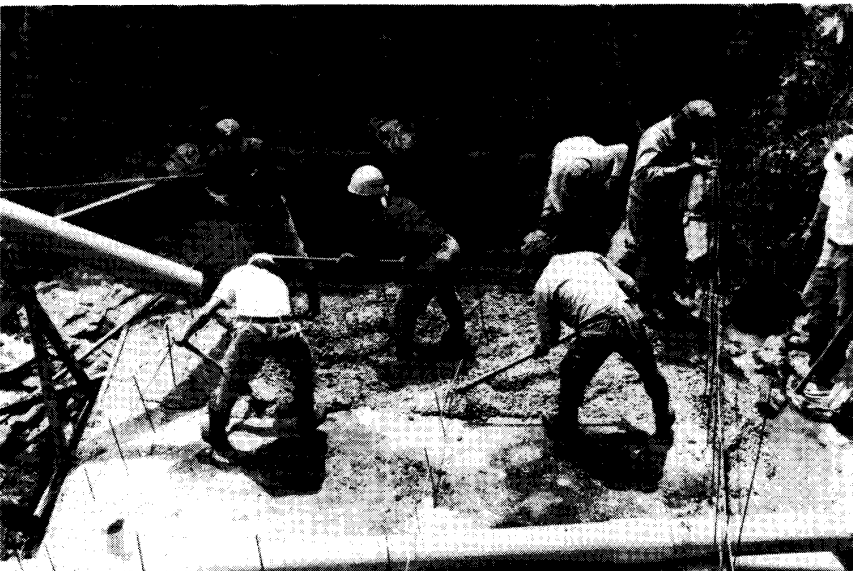
写真-5 基礎右岸部のコンクリート打込み
