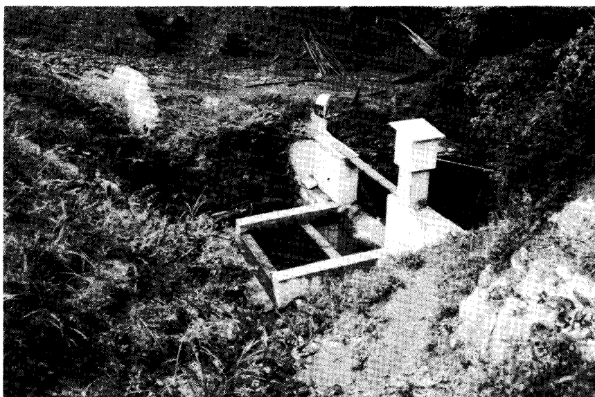
写真-16 完成後の量水施設 小屋は計器室。
