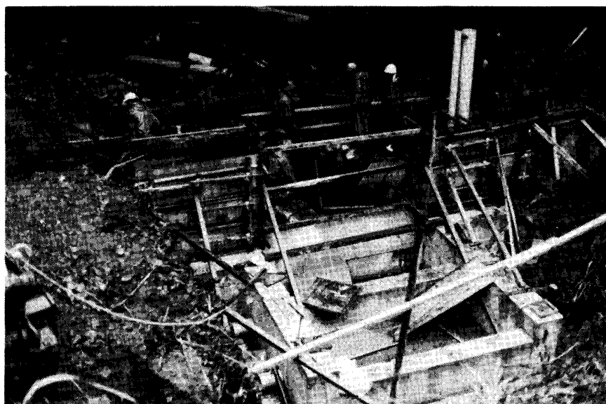
写真-12 堰堤上部および横工 の型わく組み
