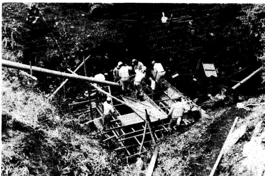
写真-10 堰堤下部および流量 測定用水槽のコンク リート打込み
