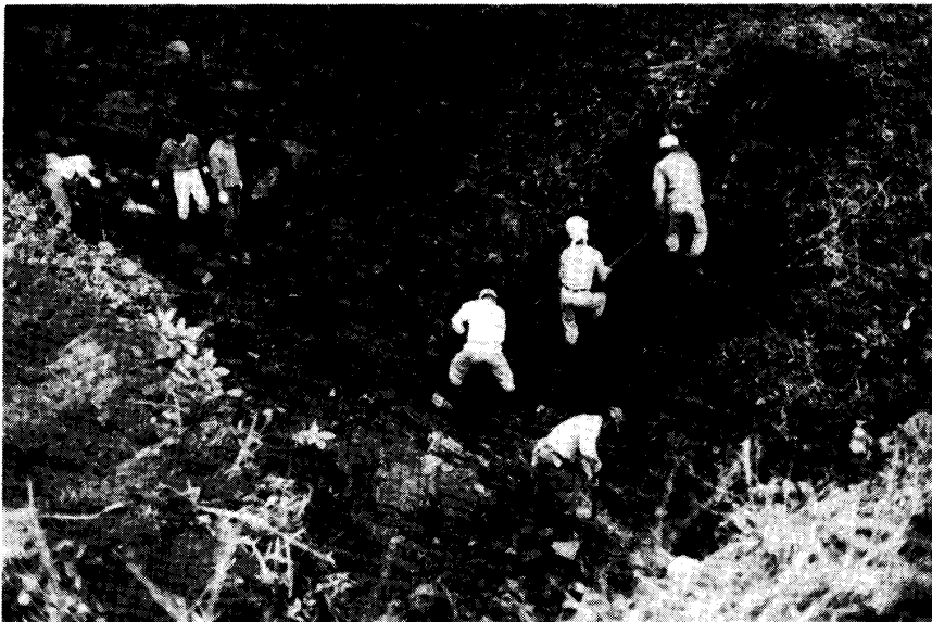
写真－2 堰堤設置位置の根掘り
