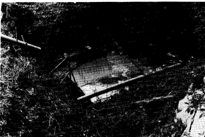
写真-6 基礎部の完成 基礎部と堰堤および流量測定用水槽の接合部には鉄筋を入れ、補強した。
