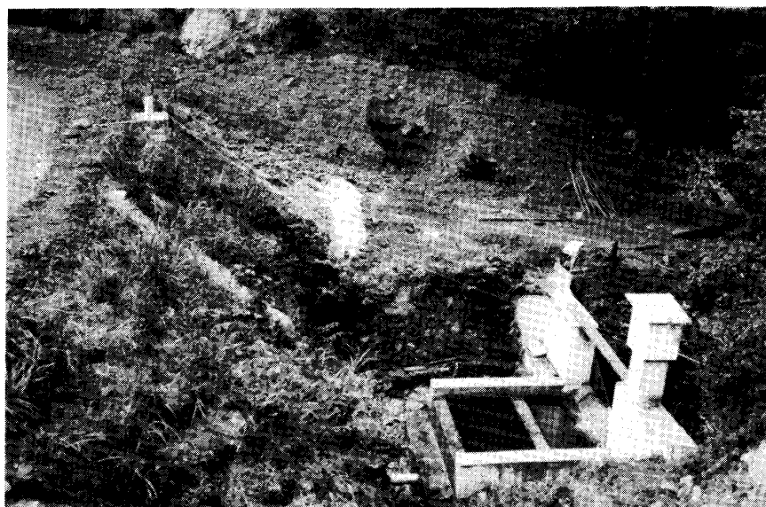
写真-18 完成後の量水施設 雨量計は林道法肩に 設置した。
