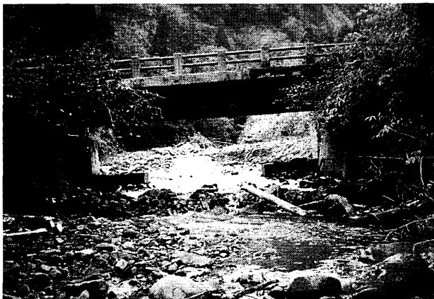
Photo.3 量水施設建設地点の整地 (下流側より撮影)
