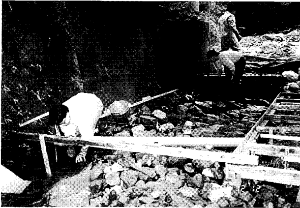
Photo.8 水路部右岸側の整地と流水引込管の 設置 (下流側より撮影, 塩ビ管は観測井 戸と水路の連絡管)
