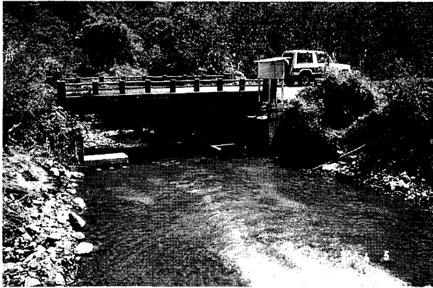
Photo.1 被災前の高隈第5号量水施設 (上流側より撮影)
