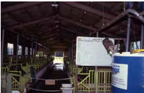
写真7 パイプライン
