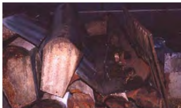
写真14 垂鉛ドブ漬け鉄製飼槽の腐食状況
