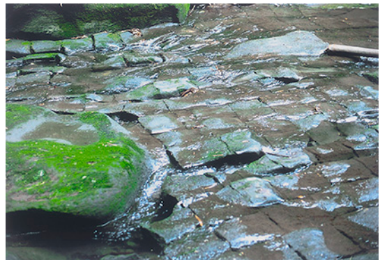
図14. 精木川河床に敷かれた溶結凝灰岩の石材；大正二年の遺構.
