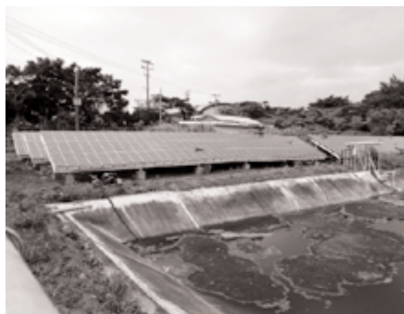
図12 太陽光発電パネルと貯水地 プロジェクト終了後は放置されている。 パネルの間から草が生え、貯水地は整備されていない
