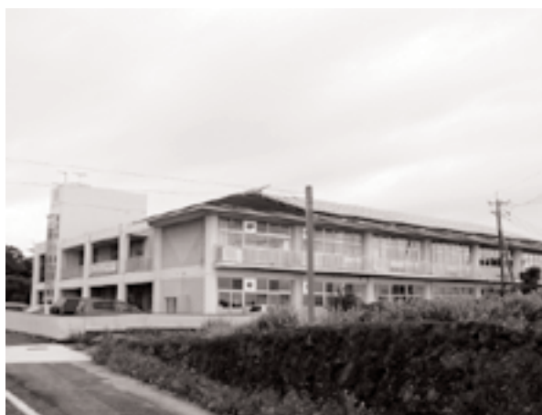
図9 知名町立下平川小学校(全景)校舎右側(南側)の屋根に太陽光発電パネルが設置されている
