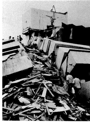
Photo 18 (d) HYATT TERRACES HOTEL Collapsed tower of hotel
