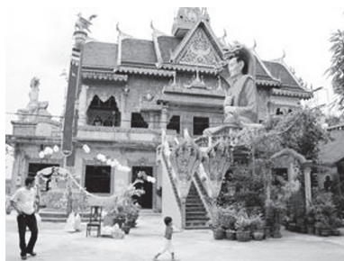
[写真135. 建設中本堂]
