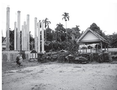
[写真156. 建設中断中の本堂]
