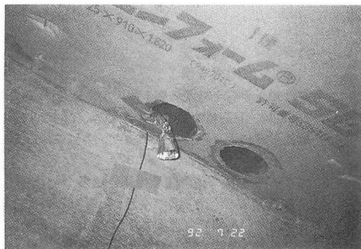
写真10 小屋裏換気孔 (25mm厚屋根断熱材が見える)
