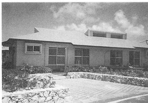
写真8 RC棟 (1棟は2戸分、対象住戸は右側)
