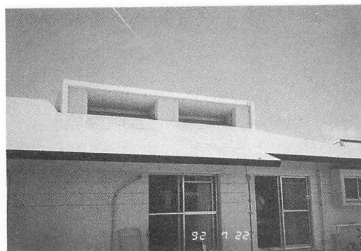
写真9 RC棟の棟換気 (写真10の小屋裏換気孔に通じている)
