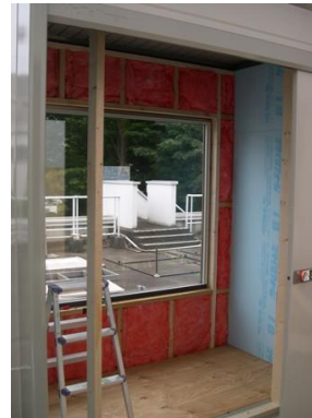
(b)正面部躯体開口（内観）
