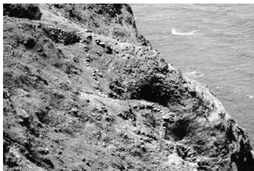
写真10. 東海岸側歩道（玉石を並べている）
