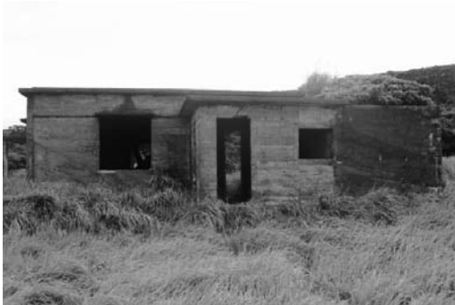
写真6. 西側荷揚げ施設
