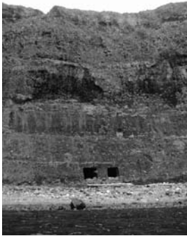
写真4. 東側荷揚げ施設
