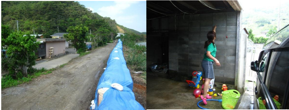
[昨年と同一カ所の決壊と応急的土嚢(戸口川)、後片づけ作業中に昨年より 30cm 高い水位であったと昨年のマーク個所と比較して示している(戸口)]
