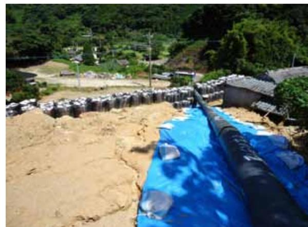
写真-3.6 排水用パイプの設置状況
