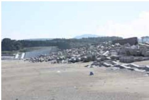
写真 1 防潮堤の破壊（田野畑村）
