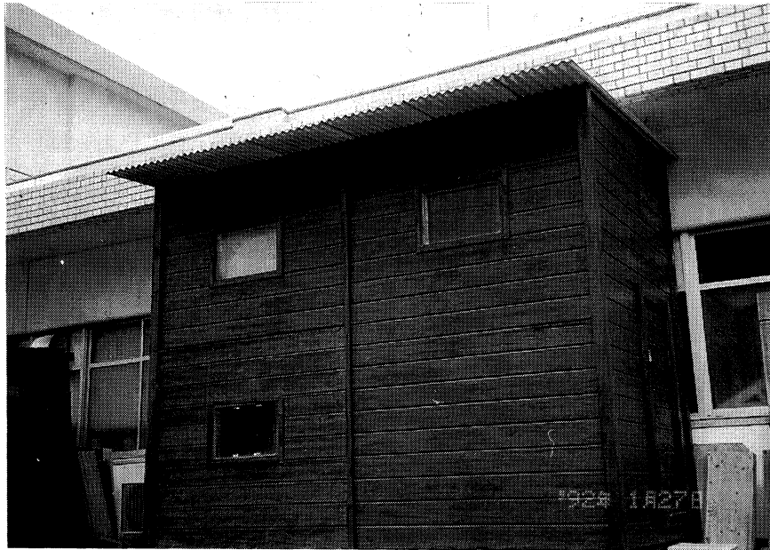
写真2 中空長柱材を利用した仮設実験棟
