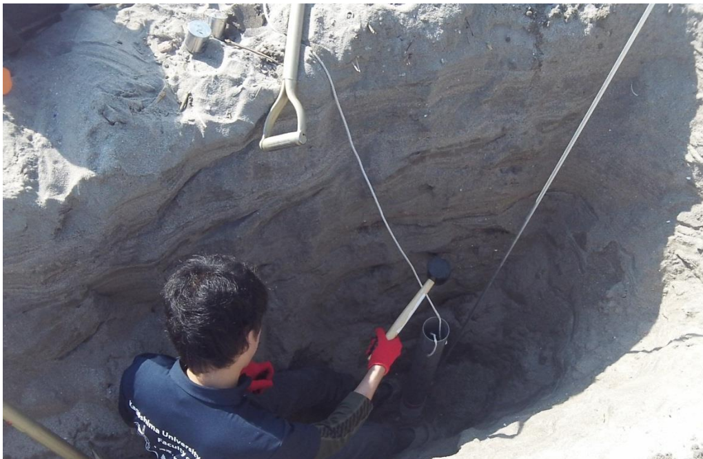
写真-2.3 観測管設置状況
