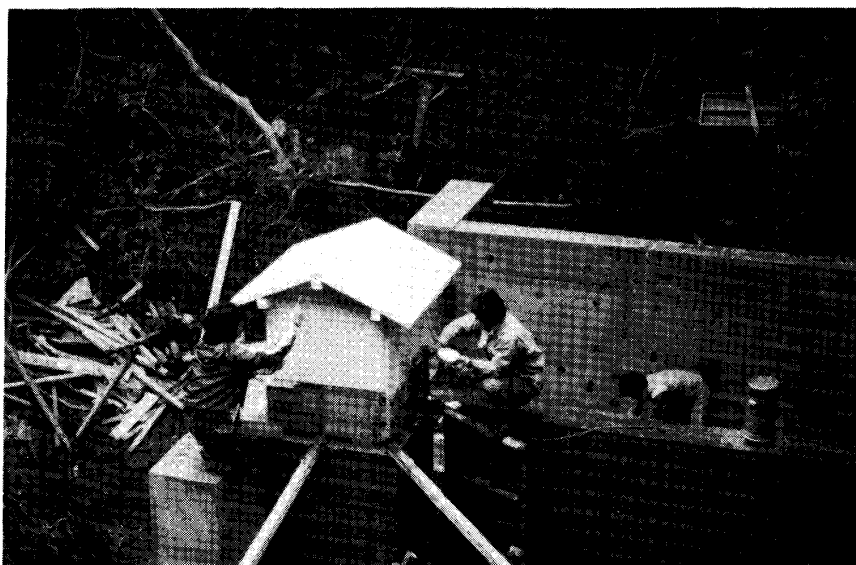
写真-7 水位雨量計の設置
