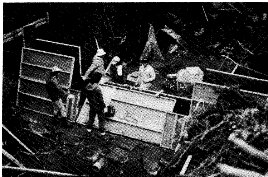
写真-5 量水堰堤の型わく組み
