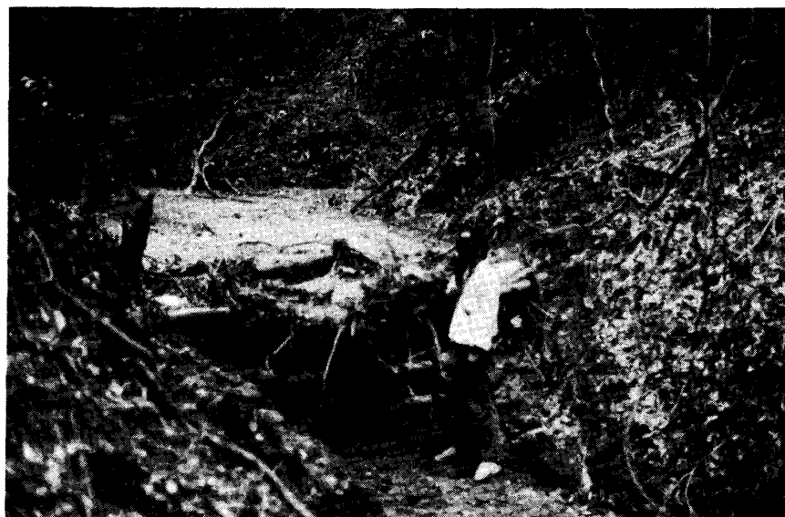
写真-12 上流に設けられた簡易貯砂ダムの堆砂状況
