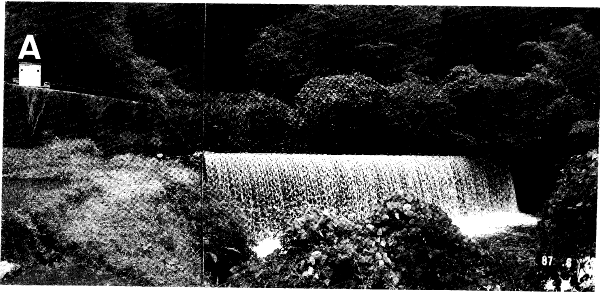
Photo.1 水位計を設置した砂防ダム A：水位計計器室
