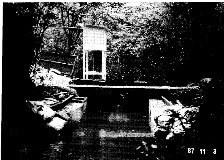
Photo. 6 完成後の量水施設 (上流側より撮影)
