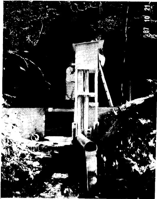
Photo. 4 量水堰堤の完成(下流側より撮影) (堰堤両袖部には排水および排土用として塩化ビニール管を埋設した。また、左岸側の塩化ビニール管は水位観測井戸に通じている。)
