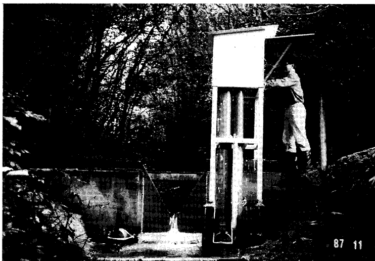
Photo. 7 完成後の量水施設 (下流側より撮影)
