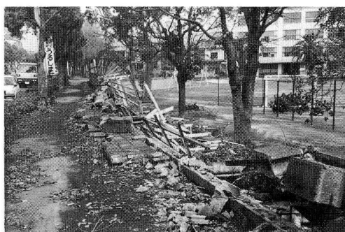
図51 ブロック塀の倒壊
