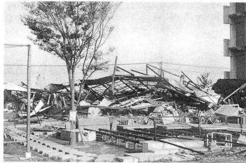
図29 明和中学校仮設校舎の被害 (A)(B)棟
