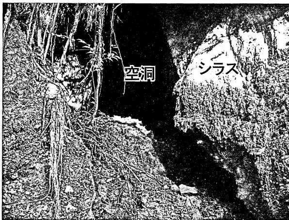
図-8 薩摩郡さつま町求名における地下水型侵食の発生状況
