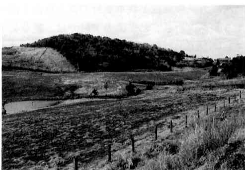
第4図 草地造成時に濁流を直接流さないよう、沈砂池を3ヶ所作った状態。
