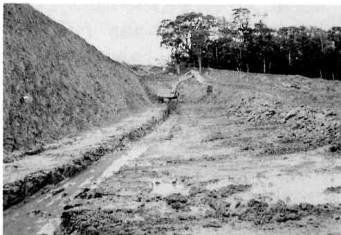
第2図 肥育牛舎の造成途中で土砂の崩壊が始まったため、排水径路を新しく作り、土砂崩壊を最小限にしようとしている作業の様子。
