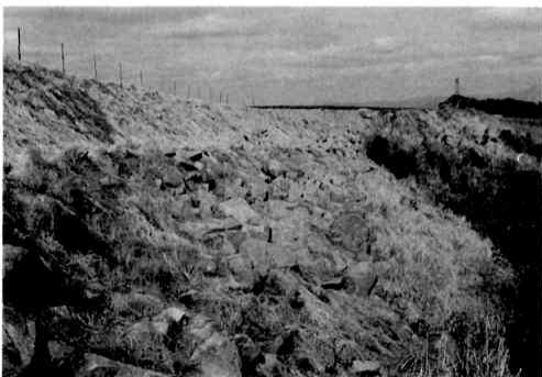
第6図 傾斜地埋め立の際、下から順次水平に押し堅めながら上の方へ上がっていき、土砂の崩壊を防止する工法で造成した草地の斜面。
