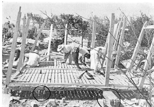
第12図 床組に用いた大材（ウドコ）○印（安木屋場）
