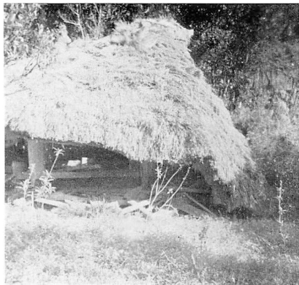
第14図 高倉の倒壊(大和浜)
