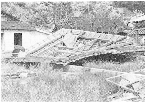
第19図 吹飛んだ鉄板葺屋根
