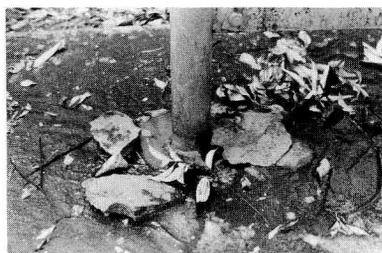
図二 柱脚部の抜出しの様子
