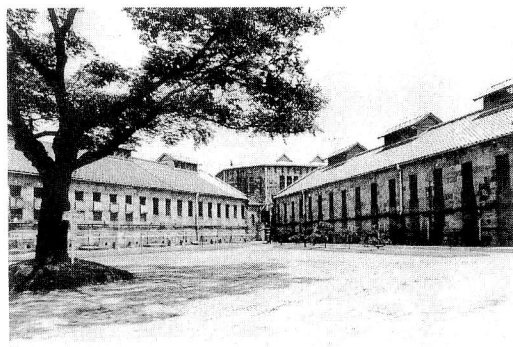
写真8 中庭からの外観
