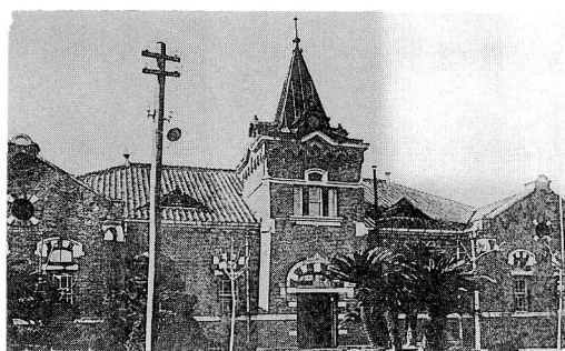
写真14 長崎刑務所庁舎
