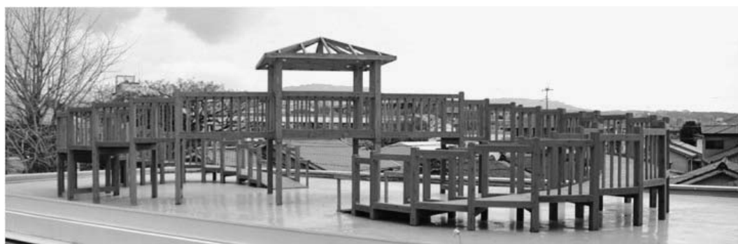
図5 「エイトラン」の施工完了時（2010年3月28日）
