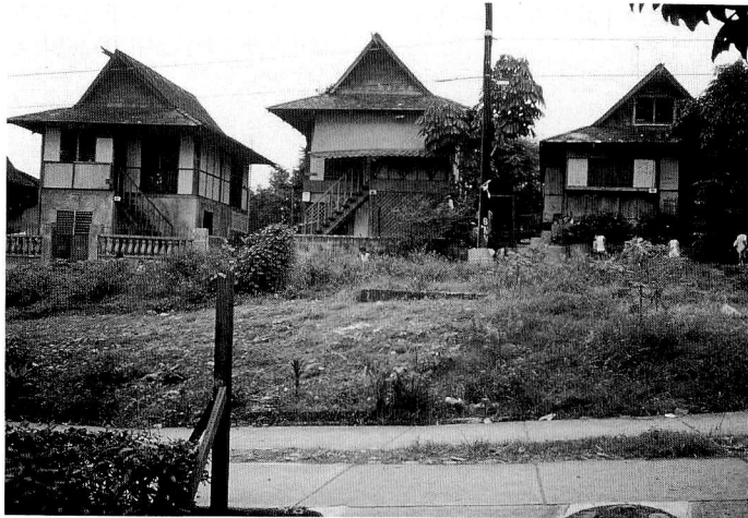
マハリカ・ヴィレッジの中級住宅。居住者の多くは政府の役人。この近くに裕福なビジネスマンが住む鉄筋コンクリート製の家屋が並ぶ（1986年9月撮影）。
