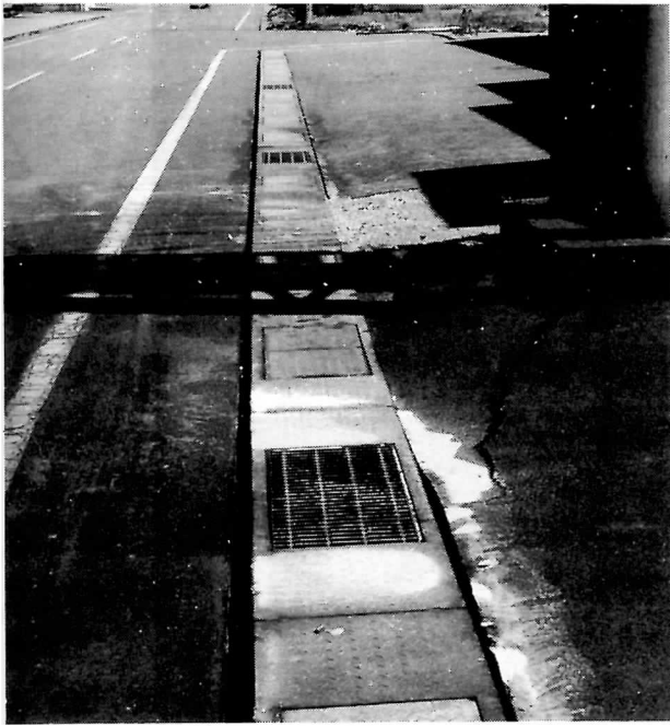
写真5. 阿久根漁港外港事務所付近の亀裂と 噴砂現象.
