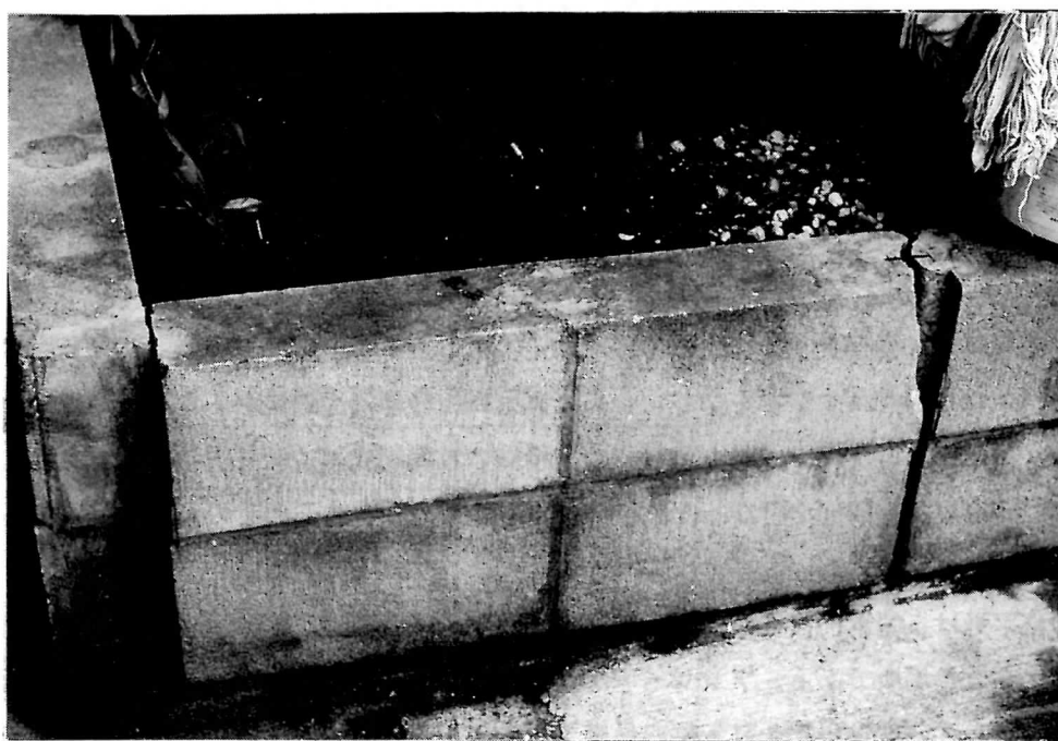
写真10. 鹿児島市錦江町における花壇の亀裂とブロックの横ずれ。
