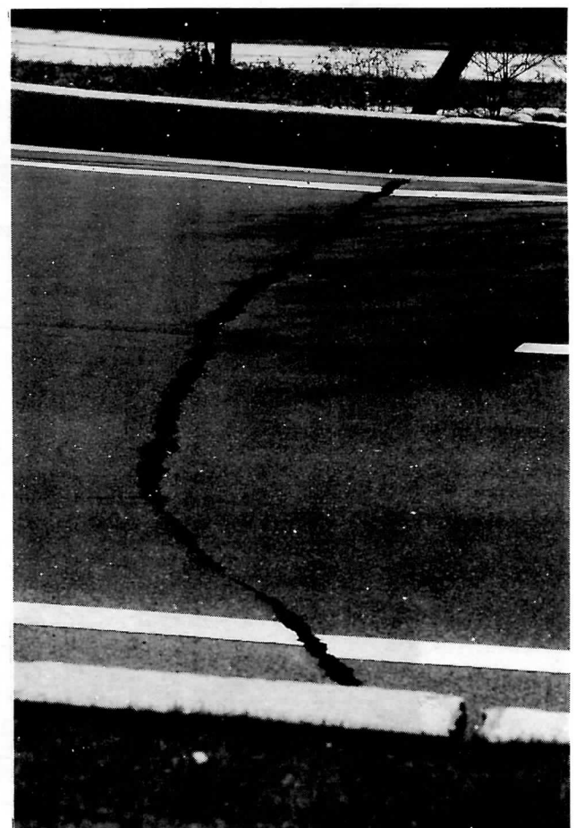
写真8. 阿久根駅前通りの、市街地と漁港の境界 付近に見られる亀裂.
