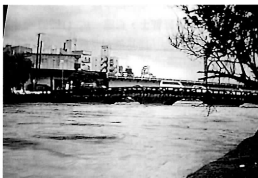
写真4. 15時頃の甲突川, 新上橋を北から望む
