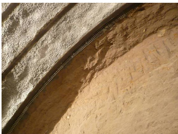
写真 4.3.1 安定した切羽 (区間①)
