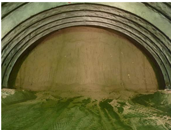
写真 7.4.5 3車線断面上半 (土被り 45m)
