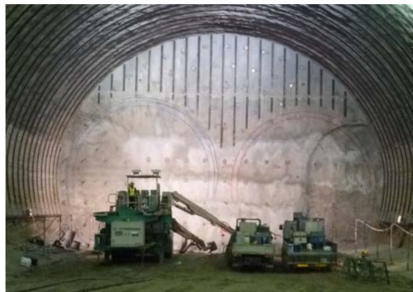
写真 8.4.2 大断面 A 妻部施工状況 (全断面)
