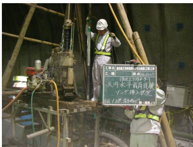
写真 5.5.1 トンネル坑内からの孔内水平載荷試験状況
