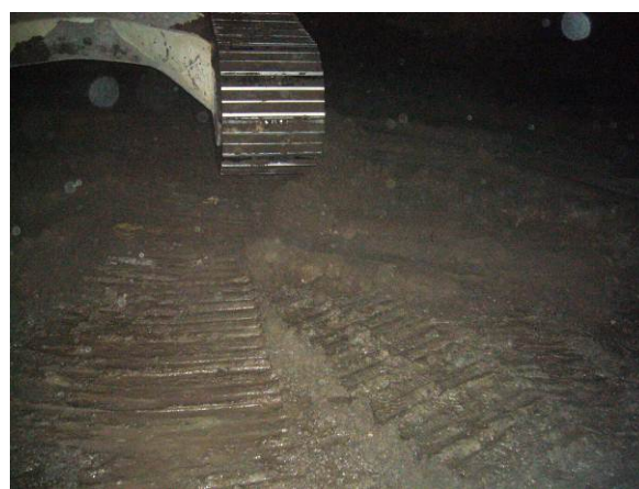
写真 4.5.2 地下水による路盤の泥濁化
