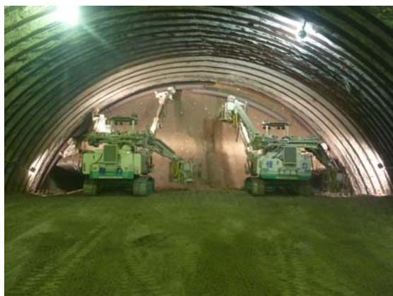
写真 8.4.1 上半支保工建て込み状況 (上半断面)
