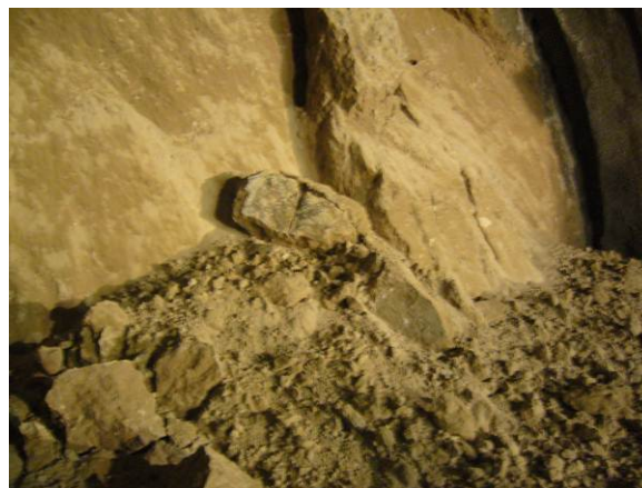
写真 4.3.6 核残しの崩壊(2)
