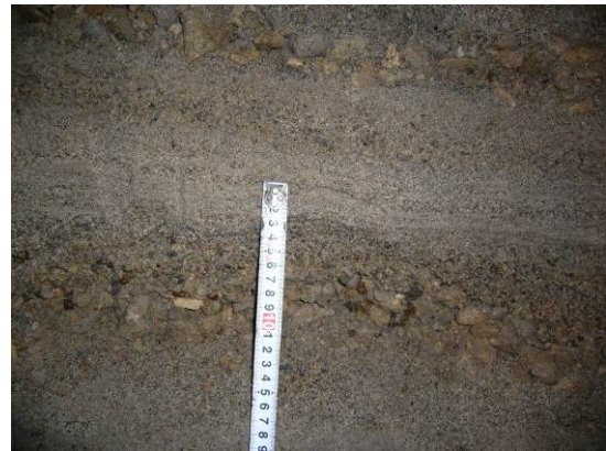
写真 4. 4. 6 新武岡トンネル切羽での二次しらす(起点側坑口) (3)
