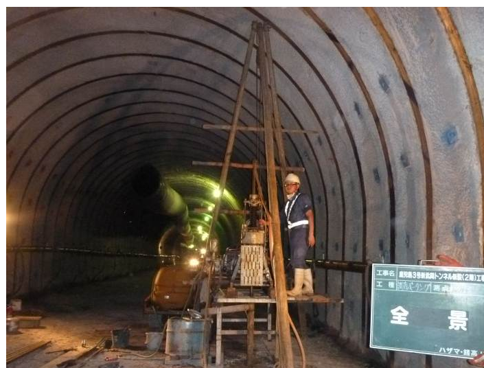
写真 5.4.2 トンネル坑内での標準貫入試験状況
