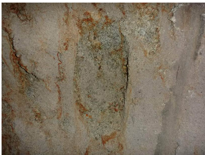
写真 4.4.3 一次しらす中の風化面(2)
