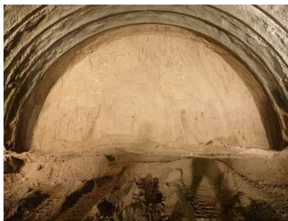
写真 4.3.2 安定した切羽 (区間①)
