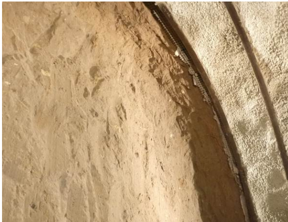
写真 7.4.3 2車線断面上半 (土被り 35m)
