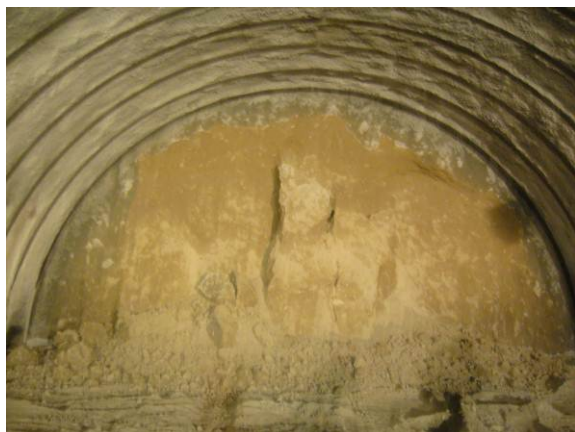
写真 4.3.5 核残しの崩壊(1)
