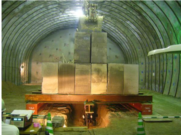
写真 5.5.2 トンネル坑内での平板載荷試験状況 (No.68 付近)
