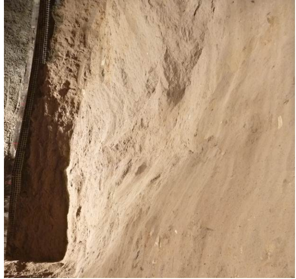
写真 7.4.2 導坑断面上半 (土被り 70m)
