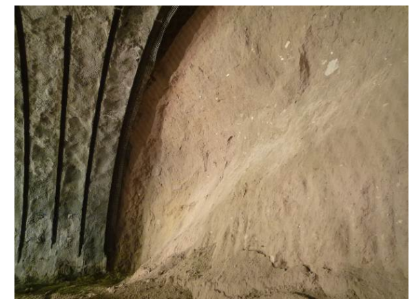
写真 7.4.6 3車線断面上半 (土被り 50m)
