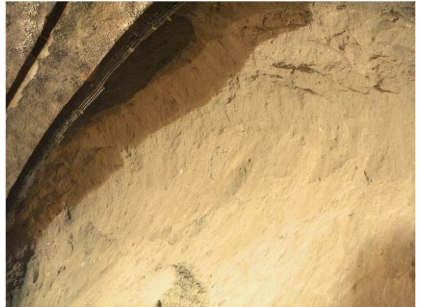
写真 7.4.4 2車線断面上半 (土被り 70m)
