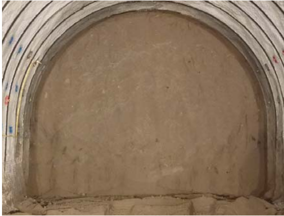
写真 7.4.1 導坑断面上半 (土被り 55m)
