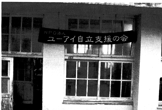
名瀬市立幼稚園の跡地を利用している
