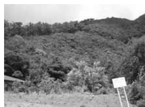
5年後 (表土流出の恐れはほとんどない)
