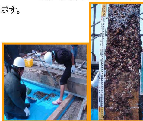
図-3 外観調査（付着生物除去）
