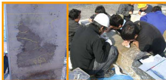
図-4 外観調査（ひび割れ観察）
