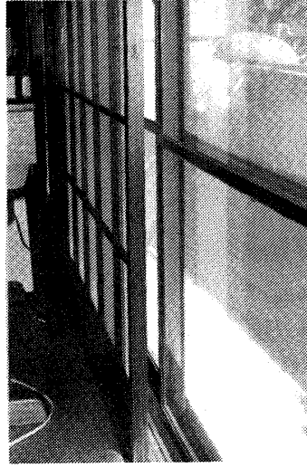
写真9 二重サッシ ・室内側にもう一つ窓・障子を設け二重にして気密性を高める。
