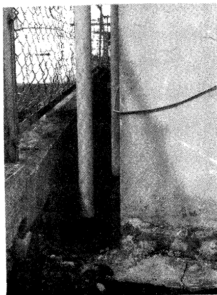
写真4 たて管の下部
