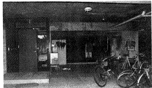
写真14 ピロディー ・物置、車庫・自転車置き場、洗濯物干し等、種々の用途を灰から守り、設置価値が大きい
