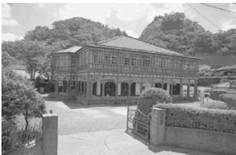
写真 33 旧鹿児島紡績所技師館 (通称、異人館)
