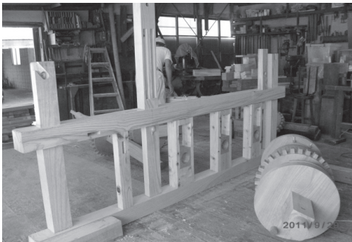
写真9 フレームの組み立て
