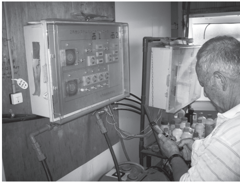
写真1 コンピュータ制御によるハウス管理 ハウス内の温度や施肥などの情報は、随時、農家の携帯電話へ送られてくる。 (2008年7月22日 筆者撮影)
